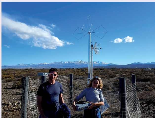
Installation du réseau GRAND@Auger par des membres de l'équipe parisienne de GRAND (LPNHE et IAP). En arrière plan, une cuve du réseau de surface du détecteur Auger.
